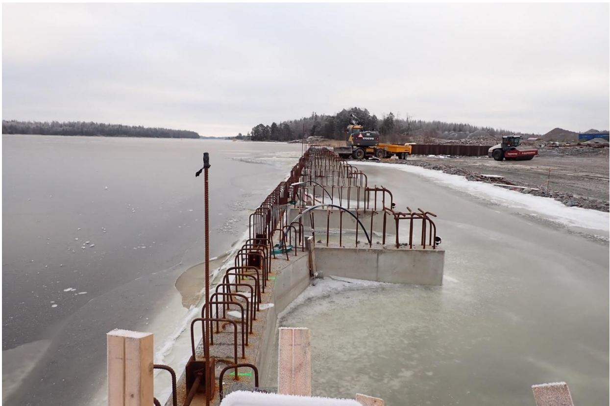
Figur 24: Stödmursegment placerad på havsbotten och delvis återfyllt på landsidan.
