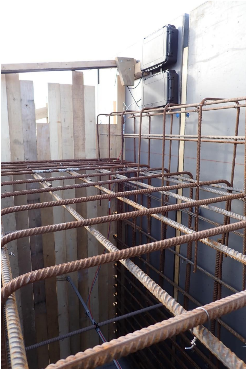
Figur 29: Plastlådor fastsatt på formen för att skydda remote modules. Den fria vertikala delen av sensorerna mellan monteringsjärn (horisontell) och armering (vertikal) visade sig skapa problem vid gjutning.
