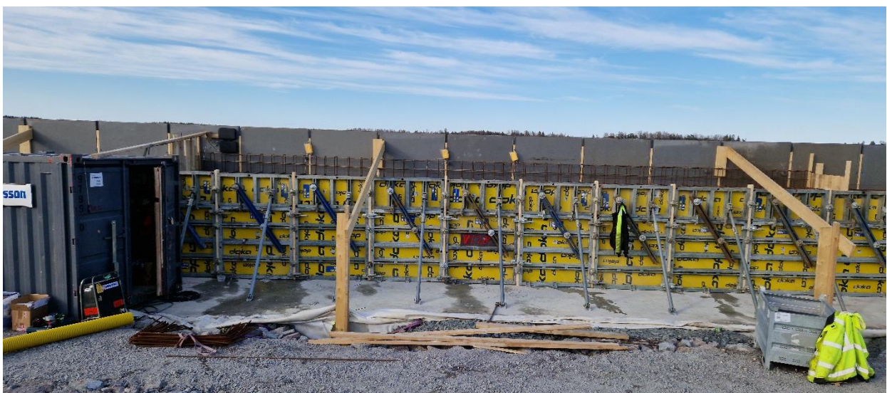
Figur 25: Etapp 128 med form på landsidan installerad. Container med mätsystem till vänster. Kablarna förs från containern via en träregel till plastboxar (skydd för remote modules). Antenn för 4G-modem under träregel.
