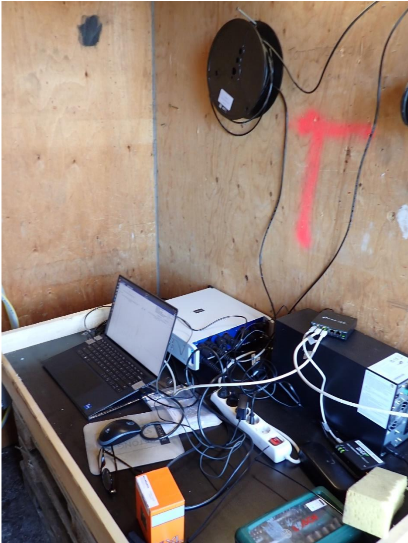
Figur 26: Container med mätutrustning.
