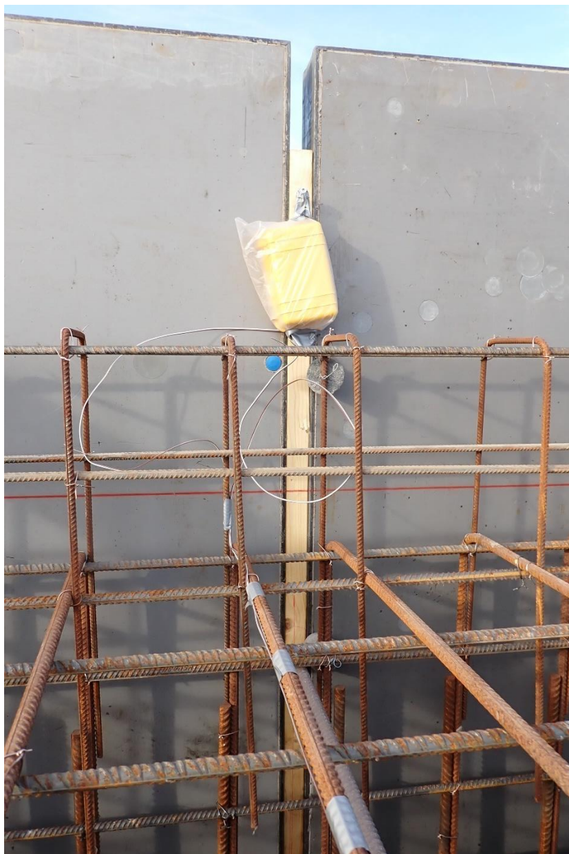
Figur 30: Installation av kompletterande temperaturmätning med system Celsicom. Termoelement tejpades till armeringsjärn och formstagg.
