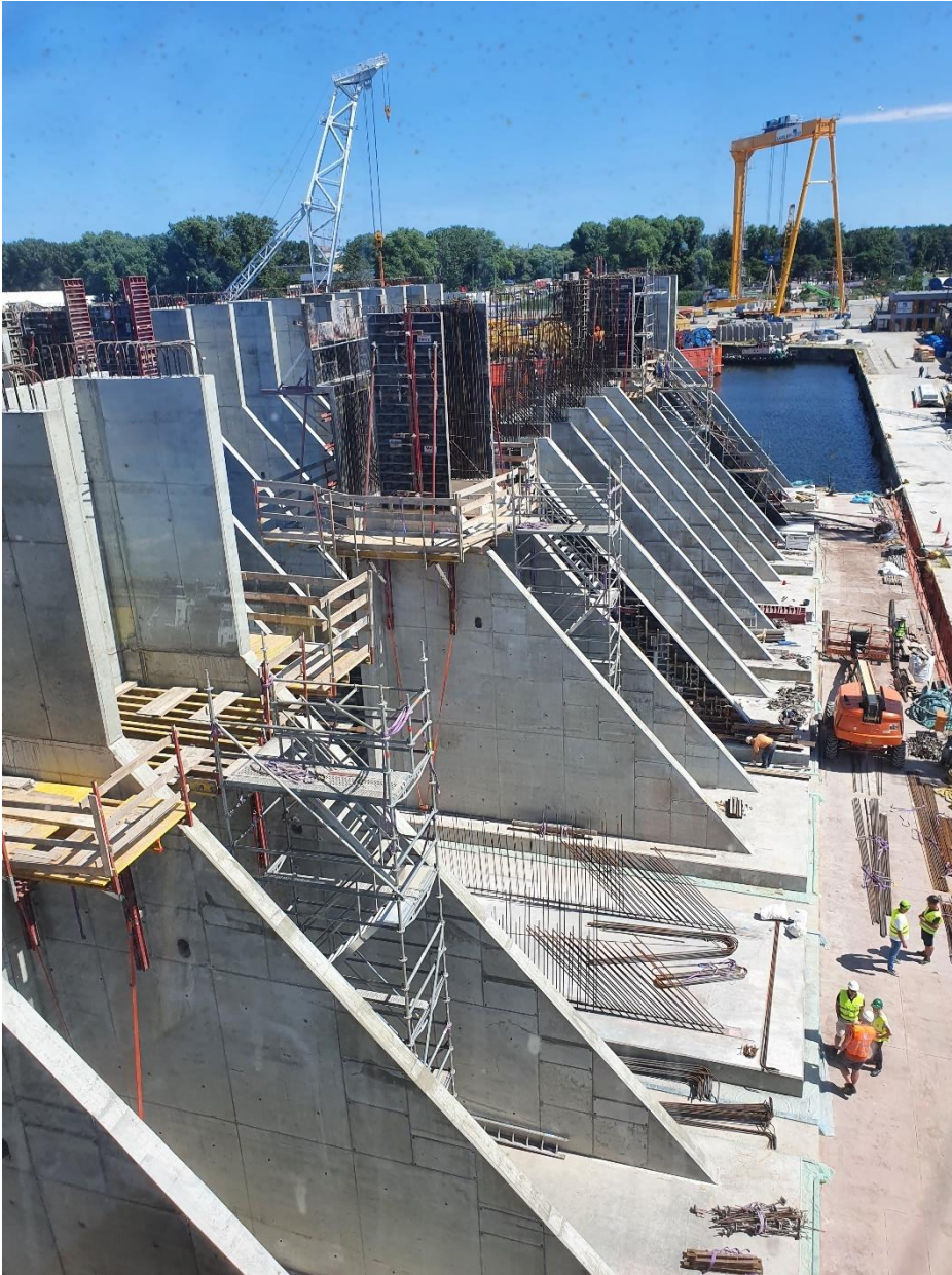
Figur 23: Tillverkning av stödmurselement. Bild tillhandahållen av Thommie Östman, Peab.
