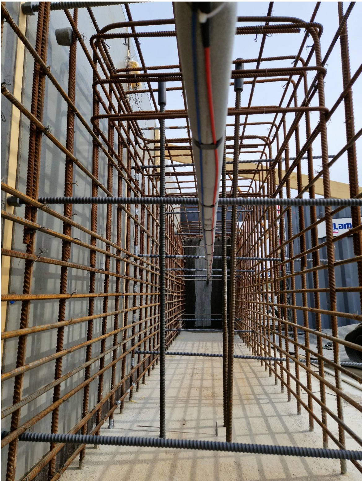
Figur 32: Installation av optiska sensorer under tejpade monteringsjärn. Avstånd på 33,3 cm mellan tejpställen.
